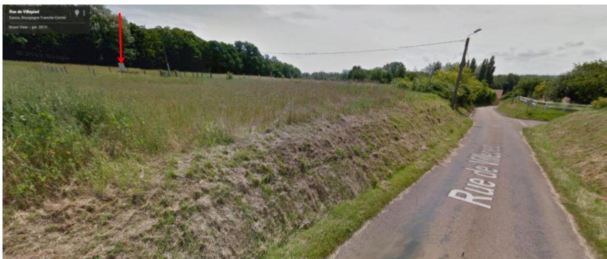
Vue du site depuis la route de Villepied en direction d'Esnon. L'ouvrage apparaît sur la gauche (extrait Google maps, vue de juillet 2013).
